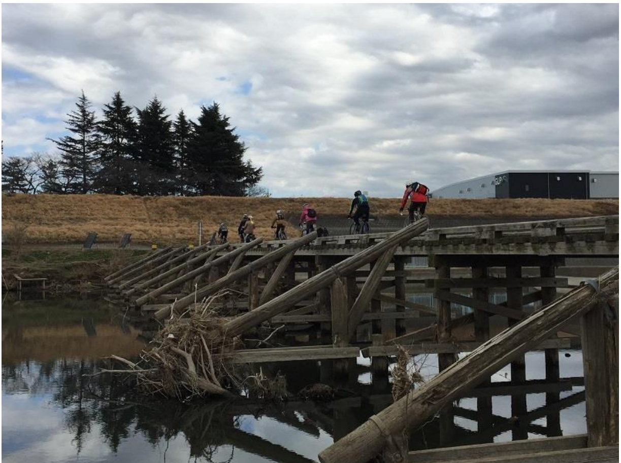
6. 越辺川冠水橋
