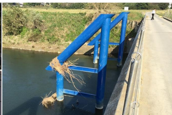
原馬室冠水橋
