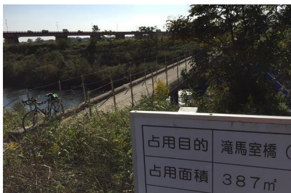
滝馬室冠水橋
